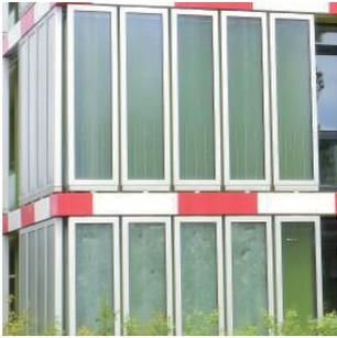
1階ガラス水槽で藻の発生する空気と水の対流が見える
