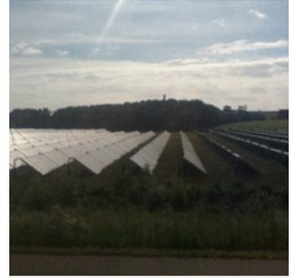
太陽光発電モジュール（パネル）のように見えるものが太陽熱温水器のパネル
